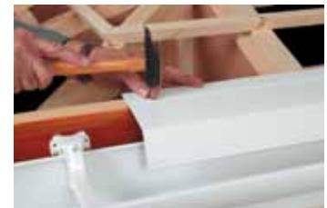
После соединения 2-х секций капельника закрепить их на месте гвоздями с крупными головками на равном расстоянии макс. 50 см. Капельник крепится к торцевой кровельной рейке. Использовать гвозди с крупной головкой для крепления капельника через овальные отверстия. Расстояние между гвоздями должно быть одинаковым и составлять макс. 50 см. Капельник необходимо установить в профиль хотя бы на 15 мм, в зависимости от модели водосточного желоба.
