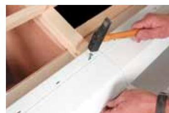
После соединения 2-х секций капельника закрепить их на месте гвоздями с крупными головками на равном расстоянии макс. 50 см.
