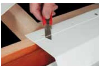
С помощью ножа сделать прорезь 10 см сквозь антикалиплярное рифление. Наложить две секции без склеивания, учитывая преобладающий ветер. Совместить 2 овальных отверстия и скрепить профили гвоздями.
